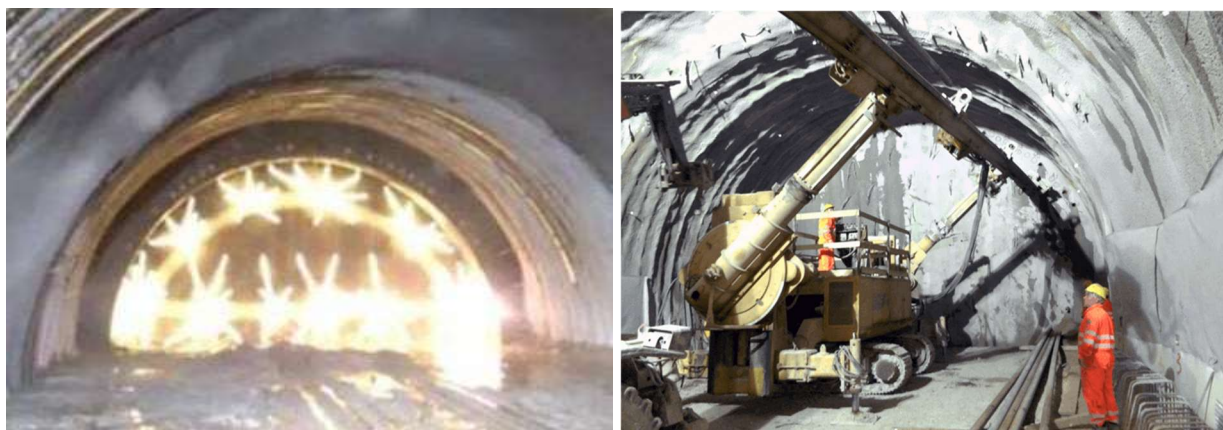
Figura 14-11 - Esempio di esplosione al fronte (a sx) dopo disposizione di candelotti di esplosivo all'interno dei fori realizzati con jumbo o trapano da galleria (a dx)
