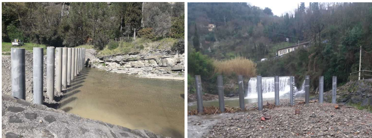
Figura 13-1 - Esempio di briglia a pettine sul t. Mugnone a Fiesole (Firenze)
