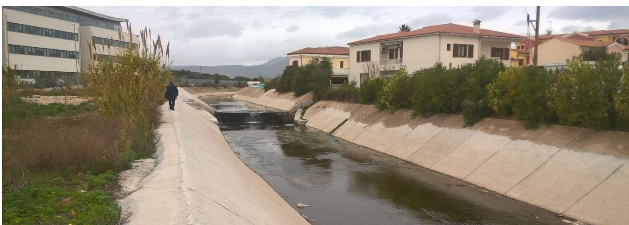
Figura 10-62 - Il rio Seligheddu (via da valle) nella zona di via Baratta: Si noti in destra idraulica il palazzo della sanità e in sinistra idraulica la mancanza di qualsiasi possibilità di percorribilità della sponda sinistra per qualsiasi intervento di manutenzione
