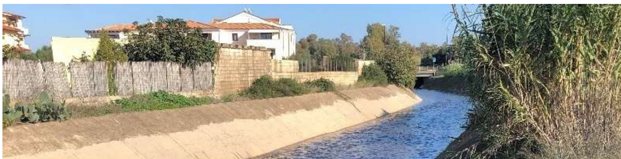
Figura 10-61 - Il rio Seligheddu (vista da Monte). Si noti la mancanza di qualsiasi percorribilità lungo la sponda sinistra che impedisce qualsiasi intervento di manutenzione all'interno del canale
