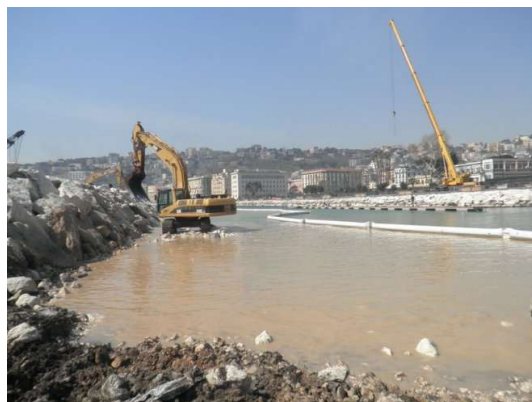
Figura 11-7 - Esempio di panne galleggianti per il contenimento di torbidità locale in fase di dragaggio
