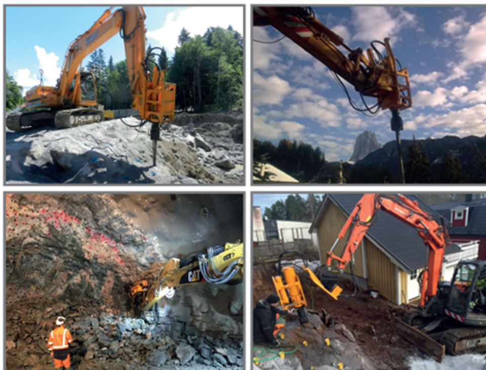
Figura 14-14 Esempi di utilizzo di un cuneo divaricatore in varie formazioni rocciose
