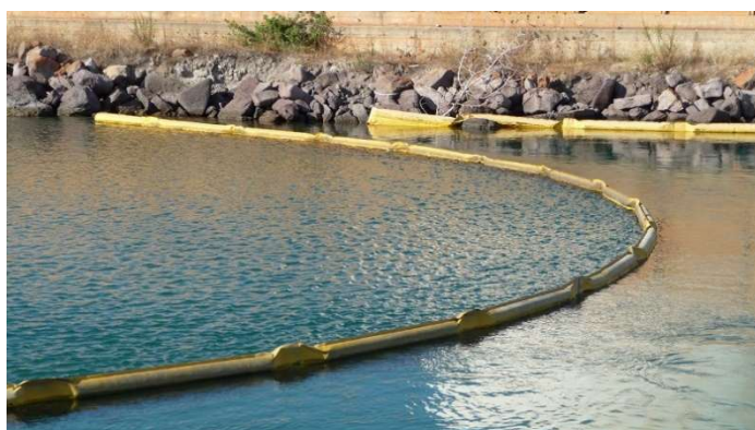
Figura 11-7 - Esempio di panne galleggianti per il contenimento di torbidità locale in fase di dragaggio
