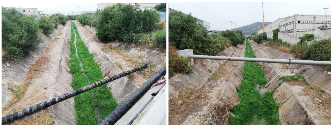
Figura 10-74 - Tubazioni di attraversamento del riu Cabu Abbas e che non rispettano il franco di sicurezza. Di tali tubazioni è previsto il rifacimento nell'ambito del presente progetto al fine di porre in sicurezza l'attraversamento e garantire il corretto deflusso della piena
