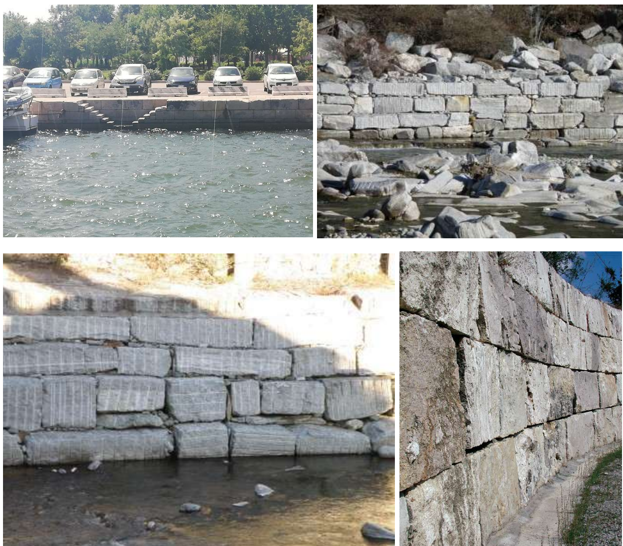
Figura 10-48 - Muro in blocchi di granito sul molo Brin di Olbia (in alto, a sx) ed esempi di muri spondali in blocchi lapidei (in alto a dx e in basso)
