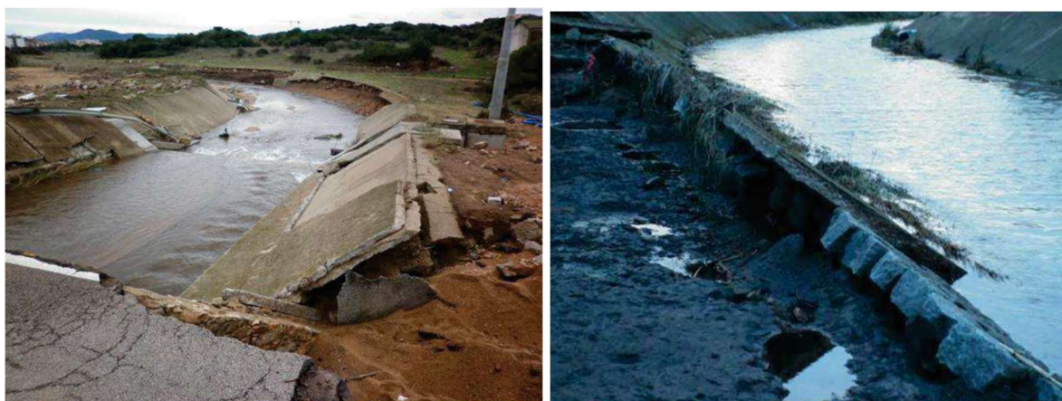
Figura 13-10 - Danni alle sponde del Riu Seligheddu rilevati dopo il passaggio della piena
