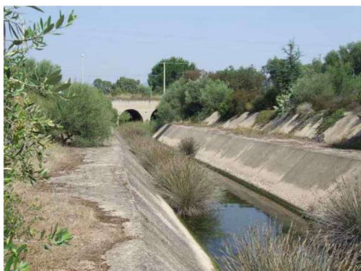
Figura 10-72 – Sezione di adeguamento (a dx) del ponte di via Indonesia in area Cipnes lungo il riu Cabu Abbas
