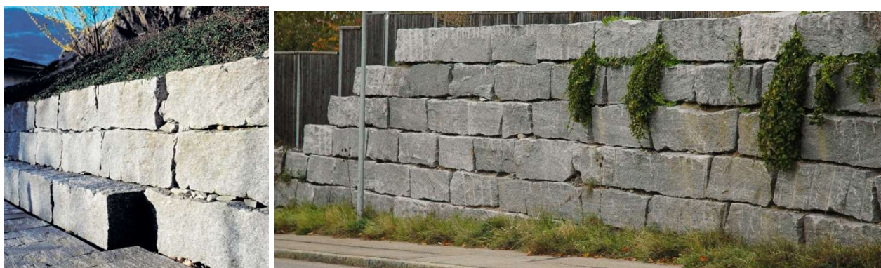
Figura 10-49 – Altri esempi di muri in blocchi lapidei
