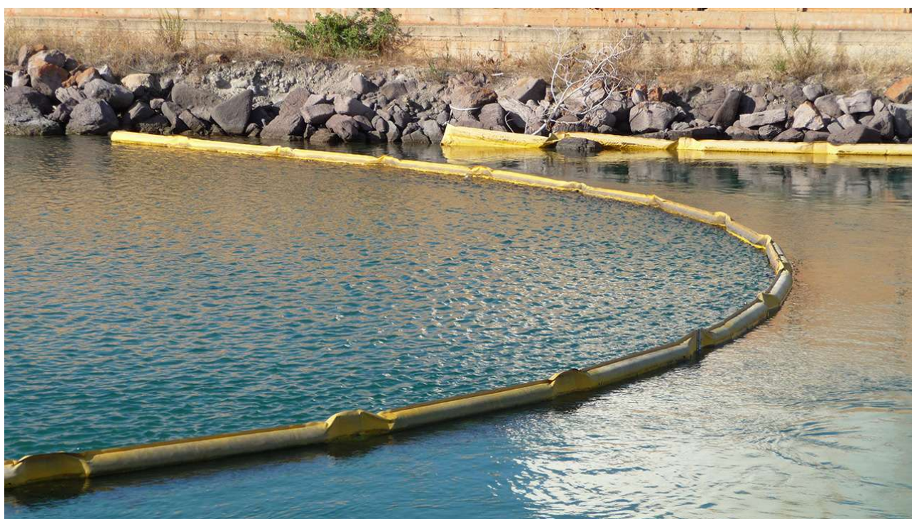
Figura 10-43 - Esempio di panne galleggianti anti torbidità
